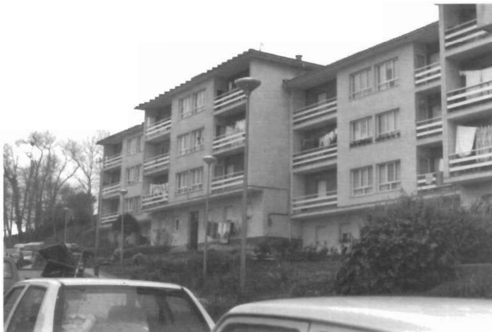
Fig. 7. Vista parcial del grupos de 40 viviendas de San Vicente de la Barquera (1990).
