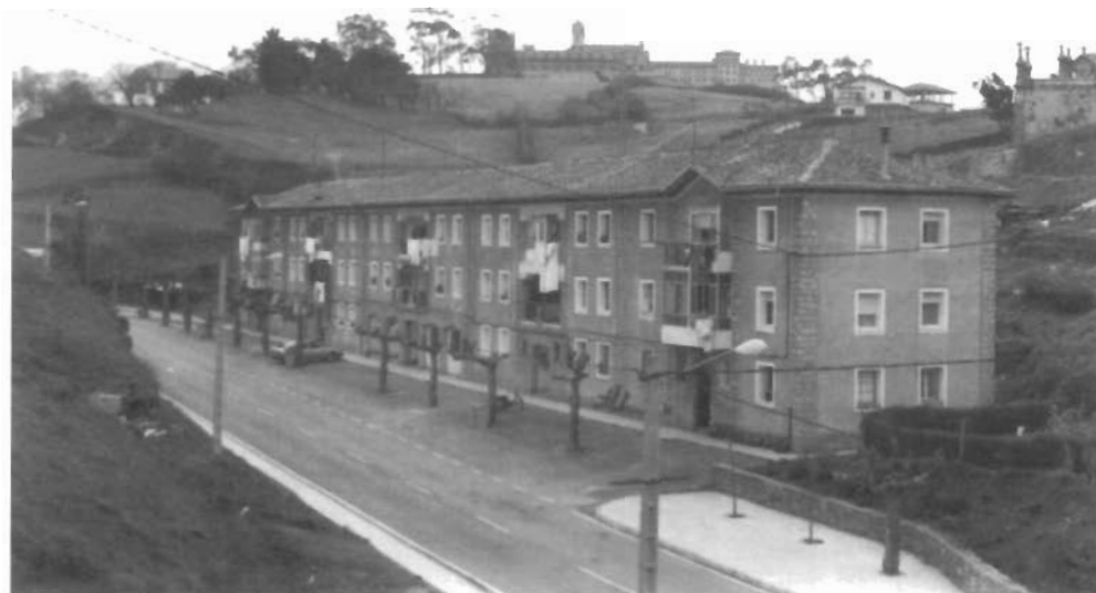
Fig. 4. Grupo de 28 viviendas de Comillas (1990).
