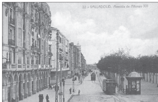
FIG. 32. La acera de Recoletos, frente occidental del falso ensanche de Gamazo, con sus edificios de elevada calidad estética y constructiva, perfectamente alineados, fue abierta a partir de 1884 y pronto se convirtió en lugar de residencia predilecto de la burguesía.
