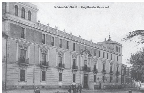
FIG. 2. El Palacio Real, uno de los más destacados arquitectónicamente de Valladolid, tuvo su origen en el que comenzó a construir don Francisco de los Cobos hacia 1522. En 1600 los marqueses de Camarasa se lo vendieron al duque de Lerma que fue quien, en 1601, trasladada la Corte a Valladolid, se lo vendió al rey Felipe III (1601) para que le sirviera de residencia (Rivera Blanco y Pérez Gil, 2002).
