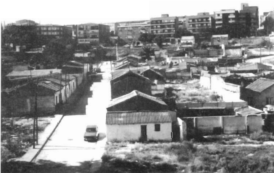
Fig. 14. Espacio marginal en el borde noroeste del Area Central junto al nuevo parque de la Ventilla.
