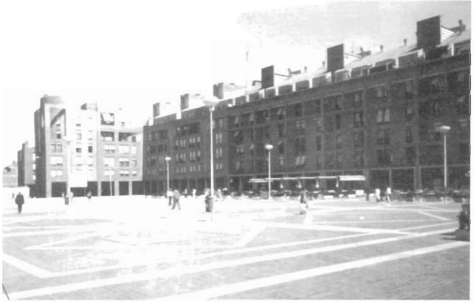
Fig. 13. Operación de remodelación y re-ualificación con vivienda pública y equipamientos sobre el antiguo cuartel de la Remonta (Distrito de Tetuán).
