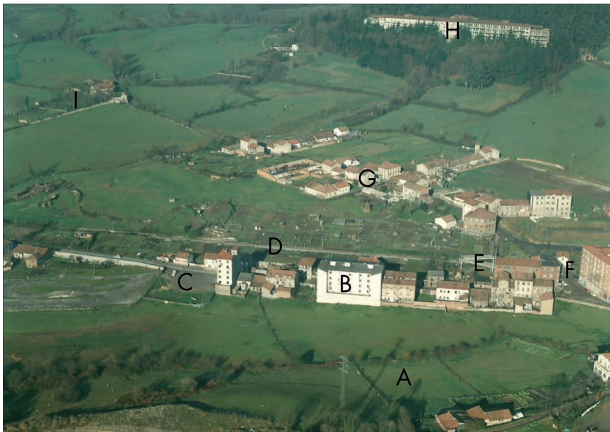
FIG. 10. Aspecto de la Florida a finales de los años ochenta del siglo xx. A) suave vertiente correspondiente al barrio de la Argañosa, donde ahora se encuentra el sector oriental del parque del Oeste. B) Lavapiés, con el caserío previo al ahora ocupado por la urbanización Pórticos I. C) Solares que coinciden con el final del trayecto del autobús urbano San Lázaro-Lavapiés (antigua Línea 5). D) Línea del ferrocarril Oviedo-Trubia. E) Pasarela sobre el trazado ferroviario de Feve que posee allí un apeadero al tiempo que facilita la conexión a pie entre La Argañosa y La Florida. F) Tradicional paso a nivel, senda obligada para acceder al barrio originario de la Florida. G) Núcleo de la Florida tradicional. H) Hospital Monte Naranco. Antes de ser integrado en la red sanitaria pública asturiana, era un sanatorio antituberculoso. I) Quinta Méndez. Una quinta de recreo que, tras la Desamortización, había levantado la familia Méndez Vigo sobre terrenos de la antigua malatería de San Lázaro de Paniceres; de donde proviene el topónimo y que empieza a demolerse al compás de la nueva edificación.
