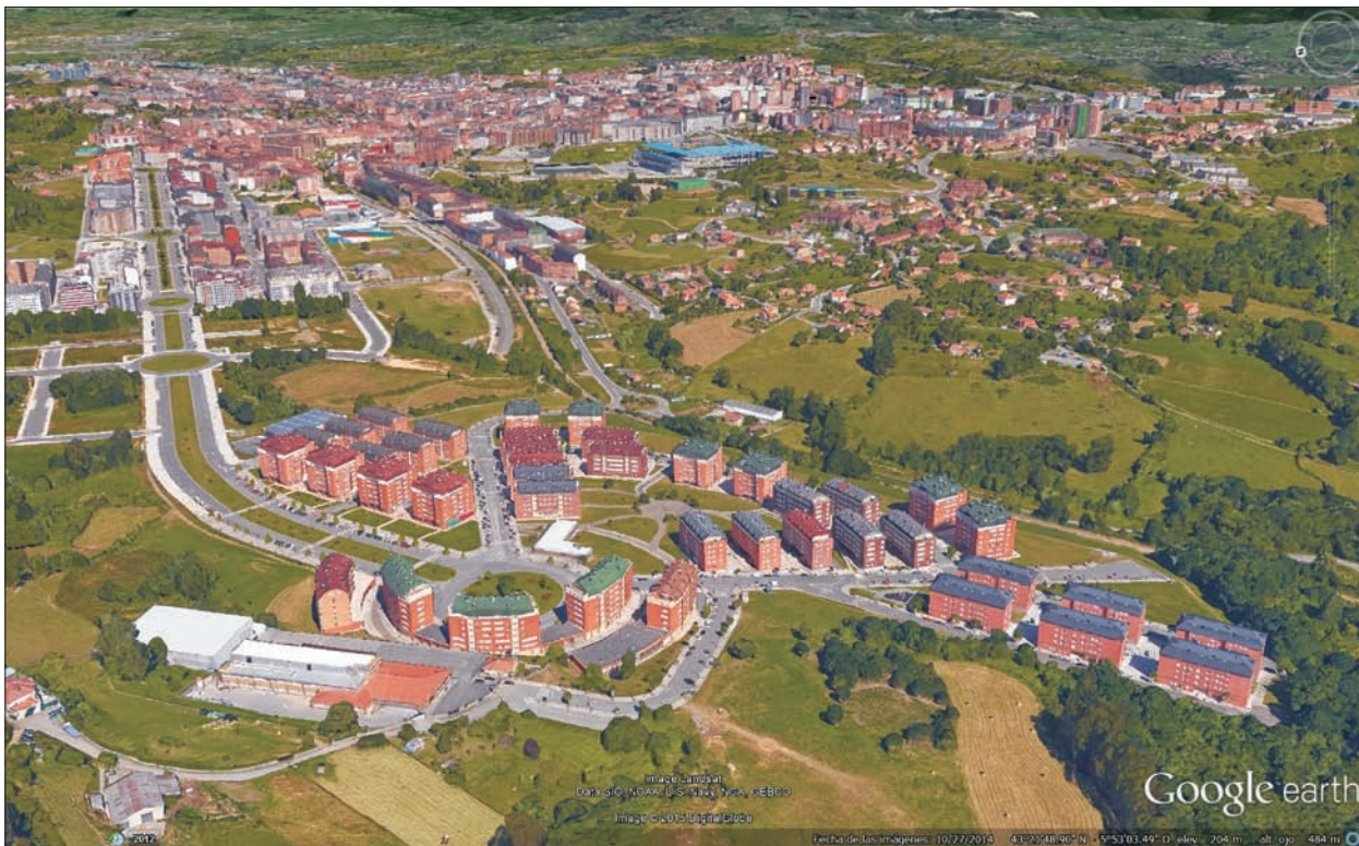
FIG. 14 Las Campas constituye la pieza urbana que sirve de remate al poniente ovetense. La elección de su tipología edificatoria de bloques exentos facilita la transición entre la urbanización difusa de Olivares (a la derecha en segundo plano) y las grandes manzanas de La Florida, espacio a través del cual, tras la apertura en 2012 del último tramo del gran bulvar, se produce su definitivo ensamblaje con la ciudad.
