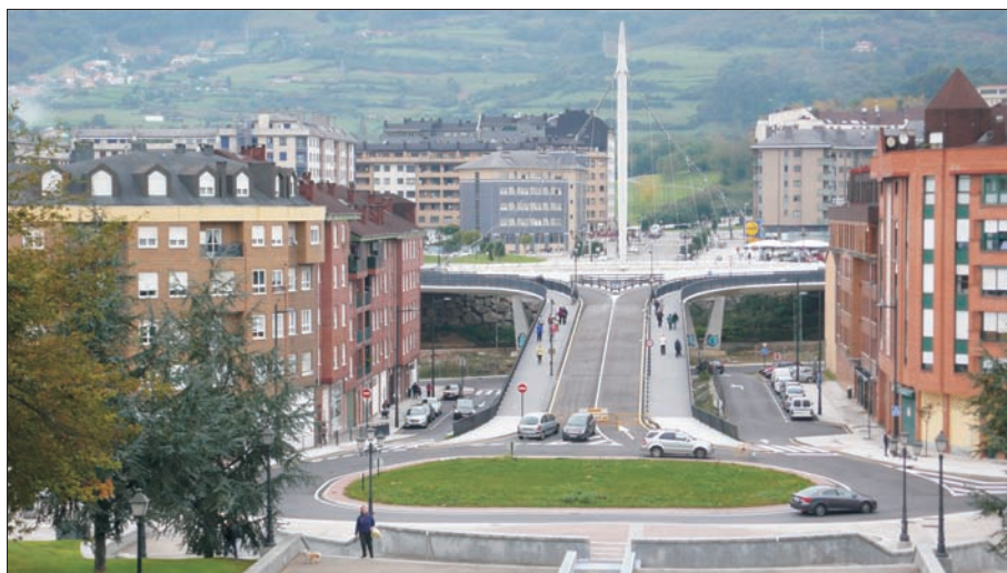
FIG. 11. Inaugurado en 2015, el puente que facilita la conexión entre La Florida y el parque del Oeste elimina, al sobrevolarla, la barrera que siempre supuso el trazado del ferrocarril de vía estrecha (Oviedo-Trubia). Fotografía: M. Madera.
