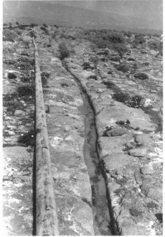
Fig. 5. Los canales secundarios o bajantes llevaban el agua desde el Canal del Sur hasta las fincas de la plataforma costera. Este ha sido excavado en un suelo de pumitas y hoy sigue funcionando en Granadilla.
