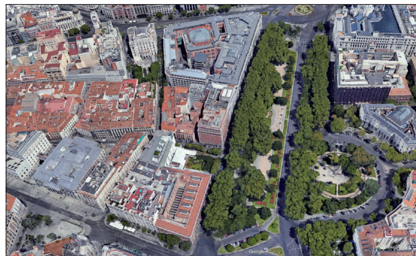
FIG. 10. Vista del Paseo del Prado entre las calles de Alcalá y Cortes. Fuente: Google Earth.
