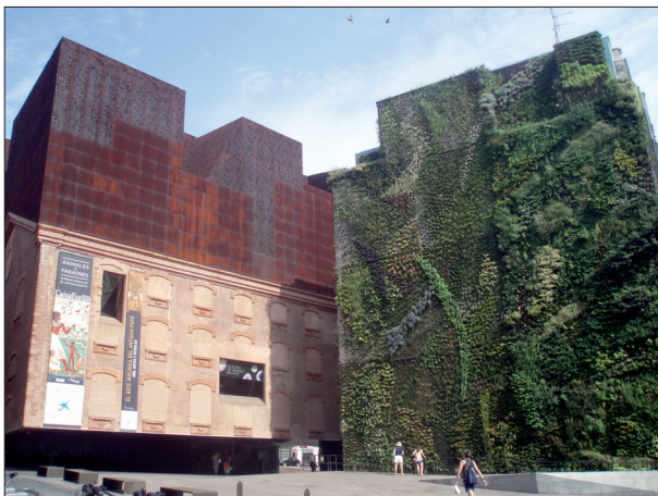
FIG. 9. A la Central Eléctrica del Mediodía construida en el Paseo del Prado en 1900 se sobrepone en 2008 la arquitectura del Centro Cultural Caixa Forum. Fuente: la autora.
