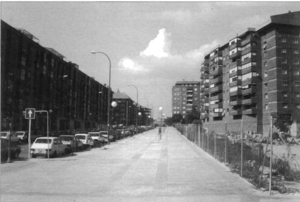
FIG. 13. Tramo central del Pasillo Verde terminado, entre la calle de Toledo y el P o de las Acacias, y bordeado por viviendas promovidas antes de la Operación.
