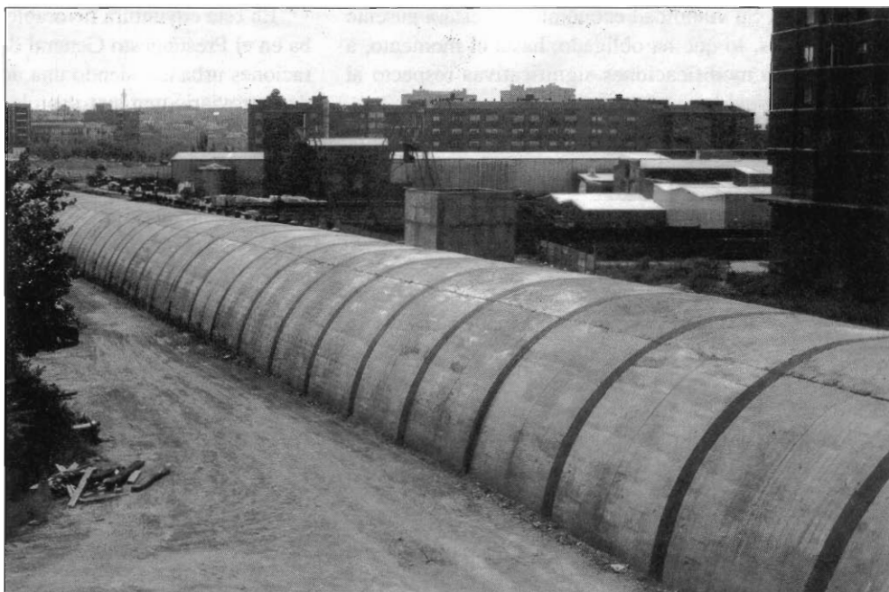
FIG. 4. Túnel de enterramiento de las vías. Situación de las obras en 1992.
