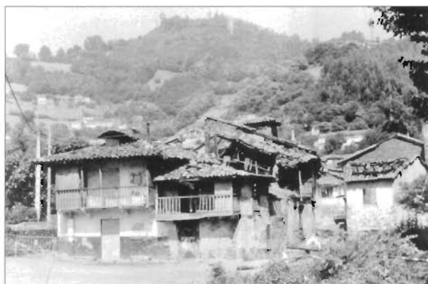
FIG. 2. La Villa, uno de los núcleos originarios de Mieres, en disposición de derribo (1999).
