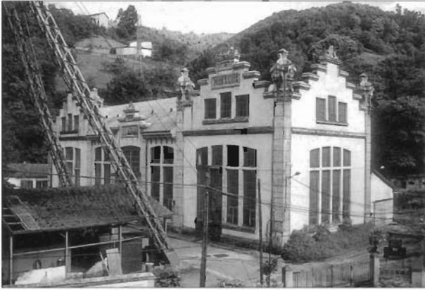
FIG. 5. Casa de maquinas del pozo San Luis.
