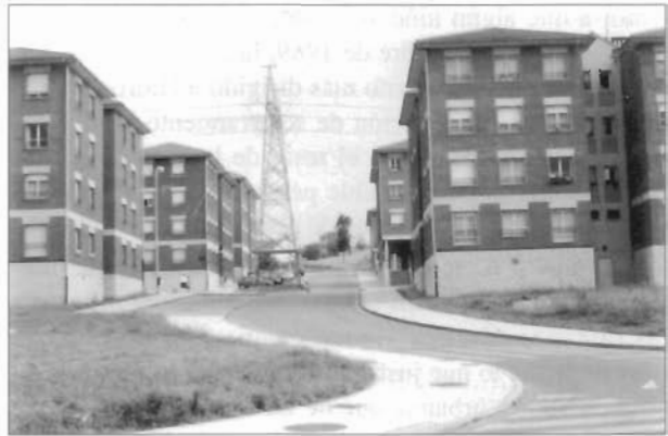
FIG. 6. Viviendas sociales del Principado de Asturias; torre de alta tensión en un cruce de calles.
