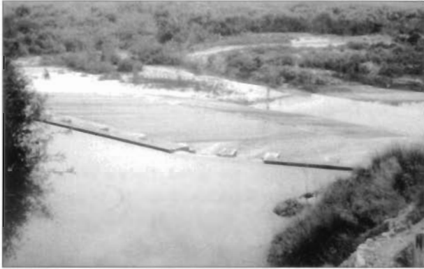
FIG. 2. Azud de la Contraparada. Hasta 1932 las únicas presas en el río Segura fueron los azudes de derivación lateral.
