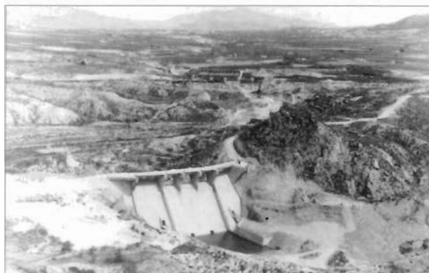
FIG. 4. Presa del Moro (5,6 hm 3 ). Las presas recientes de ramblas obedecen a la necesidad de controlar aguaduchos fulminantes y, en ocasiones, colosales (Confederación Hidrográfica del Segura).
