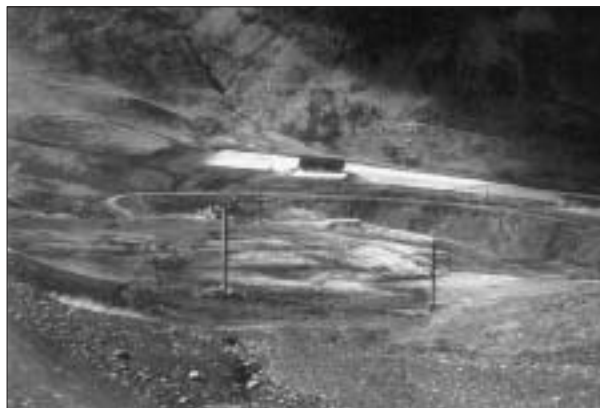
FIG. 3. Explanación para aparcamiento y edificio de servicios. Impacto topográfico-geomorfológico-paisajístico. Sector inferior del área esquiable del barranco de los Campos de Troya.
