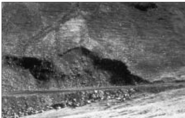
FIG. 2. Pista trazada por la margen derecha del barranco de los Campos de Troya. La ruptura del perfil de equilibrio de la ladera, sobre un depósito coluvial poco cohesionado, provoca problemas de erosión remontante.
