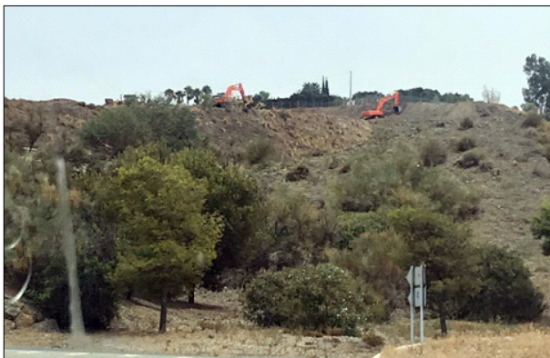
FIG. 13. Excavadoras aterrazando un cerro. Fotografías de los autores.
