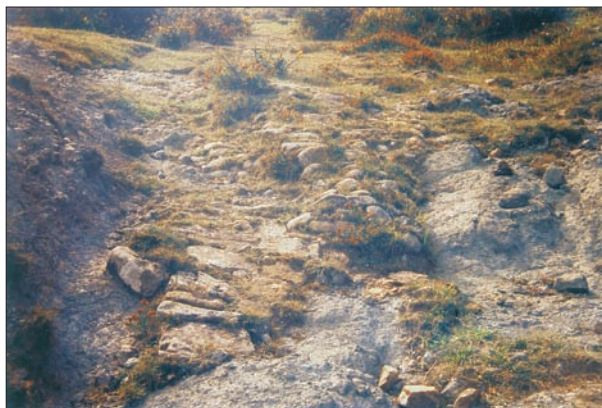
FIG. 7. Detalle del camino con diferentes niveles de firme (A. Ansola).
