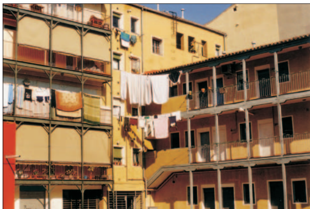
FIG. 5. Corral rehabilitado en Embajadores (Madrid).
