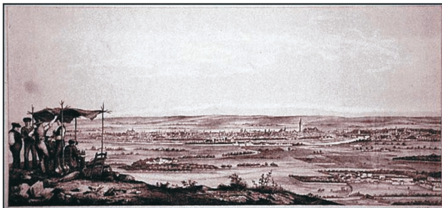
FIG. 12. Vista de Sevilla desde el cerro de Santa Brígida. Firmado por J.A.G., 1852.
