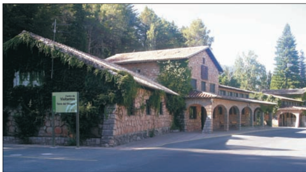
FIG. 4. Torre del Vinagre.
