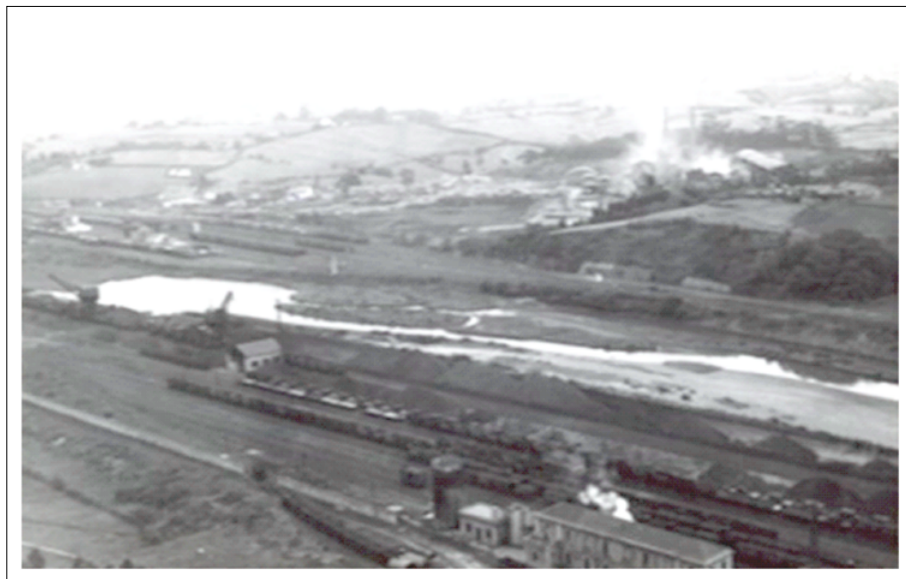
FIG. 4. Valle de Aboño en 1962, con la cementera Tudela-Veguín y el poblado obrero de La Granda al fondo. Fuente: Autoridad Portuaria de Gijón.
