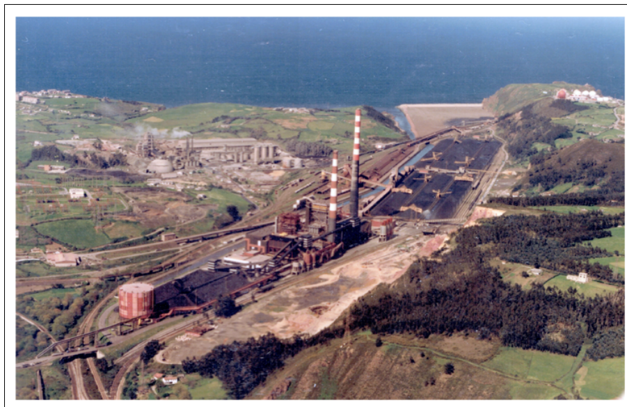
FIG. 5. En la imagen de 1987 se aprecia, en primer plano, la central térmica de Aboño ya ampliada y con la obra del parque de carbones en la desembocadura de la ría; más al fondo, a la izquierda, la cementera de Tudela Veguín. Fuente: archivo fotográfico del concejo de Carreño.
