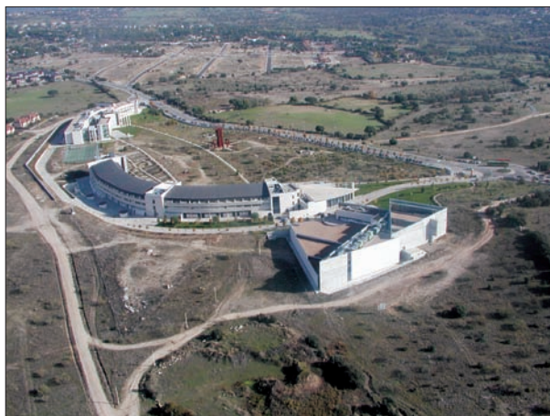
FIG. 5. Situado en el municipio de Colmenarejo, en las proximidades de Galapagar y los Escoriales, el pequeño campus norteño de la llamada en sus inicios universidad del sur , construido diez años más tarde (1999) que los de Getafe y Leganés, no deja de resultar una excentricidad en todas sus acepciones, pues dista unos cincuenta kilómetros de su sede central getafeña (en la que se encuentra el rectorado). De magnífica factura arquitectónica y de excelente localización serrana, es sede de una biblioteca especializada en fondo madrileño, una residencia de estudiantes, algunas titulaciones duplicadas y unas pocas singulares, como los estudios de turismo, que sólo se imparten aquí. Su capacidad apenas alcanza los cuatro mil estudiantes, en su mayoría procedentes de los espacios urbanos más ricos de la aureola periurbana madrileña, aunque también de la propia capital, desde donde llegan en vehículo privado o mediante autobuses de línea.
