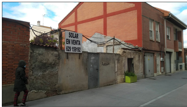
FIG. 5. Solar en venta de 90 m 2 en la calle Julián Humanes de Valladolid, correspondiente a un edificio declarado en ruina en 2002 (Serie 3122, expediente de ruina inminente 9/2002). Fuente: los autores, mayo de 2021.
