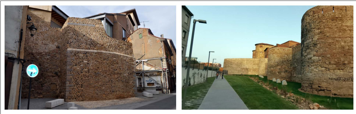
FIG. 2. La recuperación del patrimonio secuestrado. Poco a poco se van liberando pequeños sectores, escondidos o cercados, junto a la muralla romana de la ciudad que vuelven a ser de dominio público. Dos buenos ejemplos se muestran en las imágenes: a la izquierda, la calle Conde Rebolledo con el derribo de edificaciones adosadas a la muralla romana en su lienzo sur y la expropiación de las parcelas resultantes; a la derecha, apertura del paseo de la Era del Moro, en su paramento norte. Fotografías del autor.
