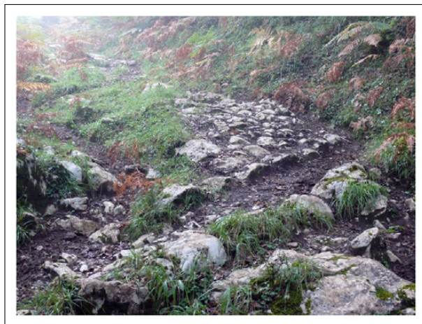
FIG. 6. Restos de canalillo transversal sobre firme empedrado. Fotografía del autor.
