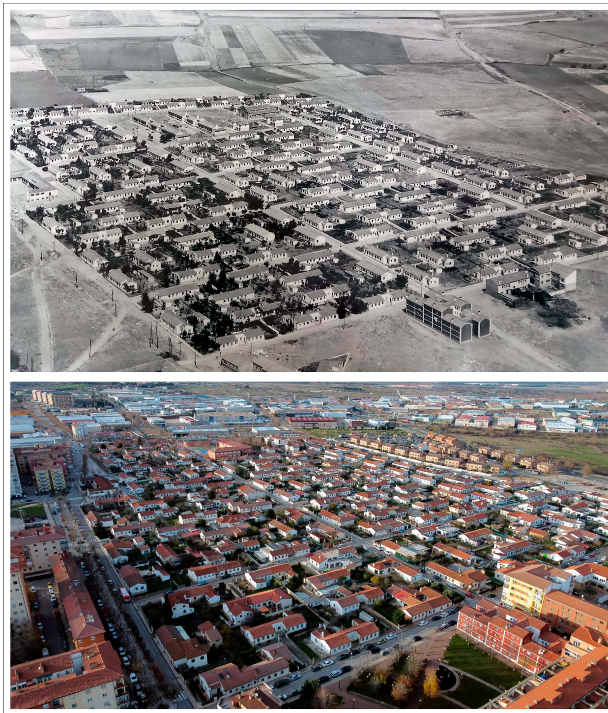
FIG. 12. Contraste en el entorno de La Barriada entre la etapa inicial y la actualidad. La foto más antigua, extracto de la original, muestra las características del barrio cuando se construyó, aún aislado de la ciudad. Posteriormente, el tejido urbano de Soria se ha extendido hacia las tierras llanas del oeste, cercando el antiguo barrio. En la imagen actual aparecen la avenida de Valladolid (a la izquierda) y el polígono industrial Las Casas (en la parte superior), ejes sobre los que se ha articulado la expansión de la ciudad. La figura refleja las diferencias de volúmenes y alturas de La Barriada, con una uniformidad que el nuevo plan de protección intenta preservar con respecto a las nuevas edificaciones que se levantan en la citada avenida. Fuente: AHPS, caja 14 845; fotografía actual tomada mediante dron por Alberto Redondo.
