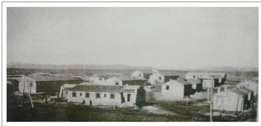
FIG. 3. Casas de La Barriada en la primera fase de construcción. Fuente: Archivo Histórico Provincial de Soria (AHPS).
