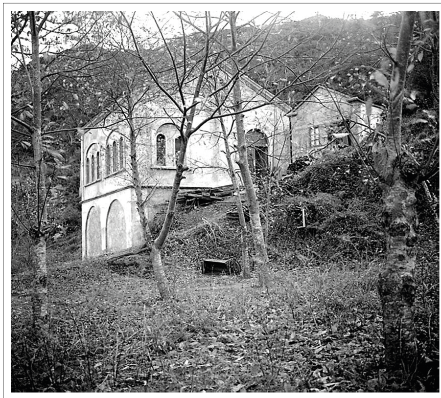
FIG. 10. Central eléctrica en Paredes (Valdés) propiedad de la Electra del Esva. Fuente: colección Fernández Lavandera, Museo del Pueblo de Asturias.
