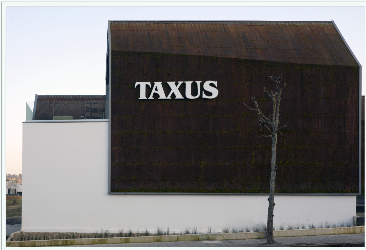
FIG. 3. Cubierta vegetal con sistema de recirculación de agua para captar precipitación de lluvia a reutilizar en el riego de la cubierta. Fuente: Taxus Medio Ambiente.
