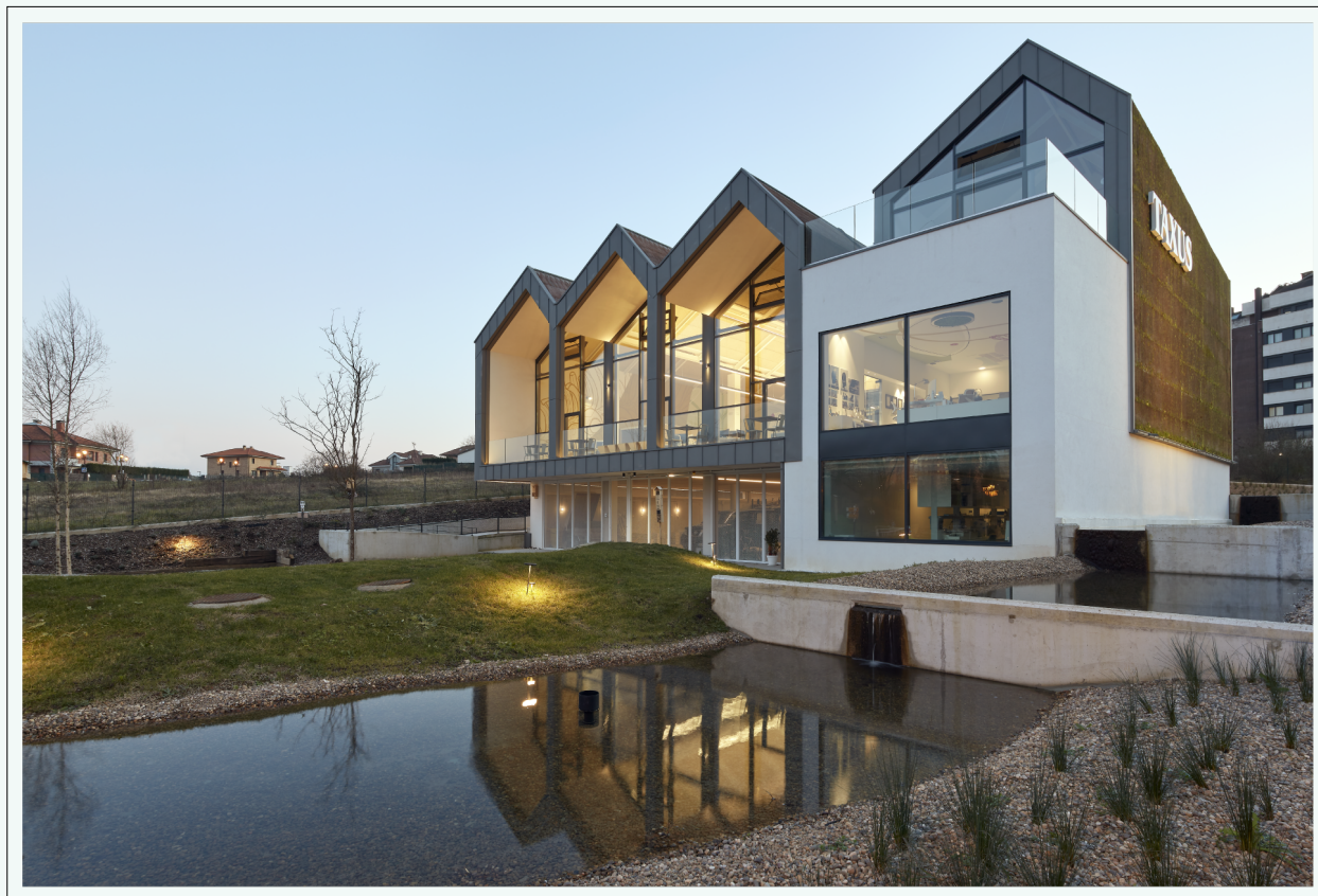
FIG. 4. Estética, confort y eficiencia han guiado la concepción del TAXUS'PEB. En el exterior, llama la atención la canalización del excedente de agua procedente de las cubiertas, que es dirigida hacia un sistema de estanques integrados de forma escalonada en el jardín. De este modo se evita la saturación de la red de saneamiento y el deterioro estético por la humedad. Fuente: Taxus Medio Ambiente.
