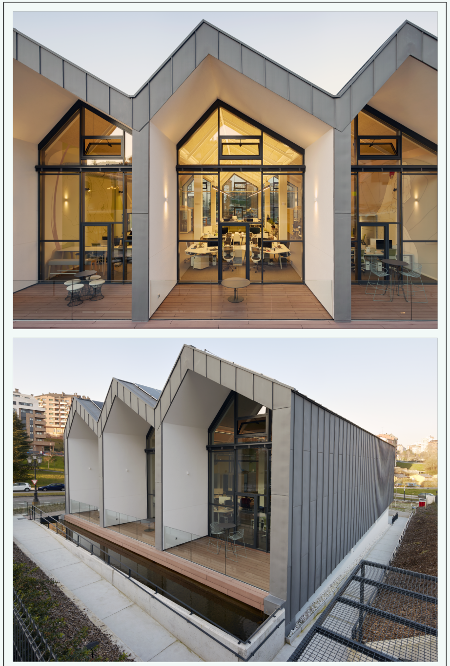
FIG. 6. La sede de TAXUS ha sido concebida como edificio residuo cero. Se ha dado prioridad a materiales de origen natural, reciclables e inocuos, como los áridos del jardín exterior y el hormigón celular libre de químicos en los muros. La sostenibilidad viene a confluir con la integración paisajística en la conformación de un nuevo modelo de ecosistema de trabajo. Fuente: Taxus Medio Ambiente.
