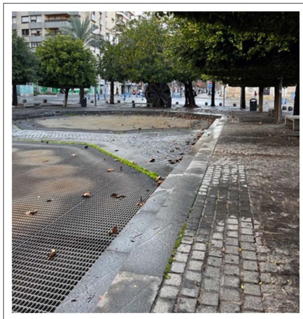
FIG. 3. Entrada de uno de los colectores construidos tras las inundaciones de septiembre de 1997 situado en el centro de la ciudad de Alicante, en plaza de España. Fotografía de los autores.
