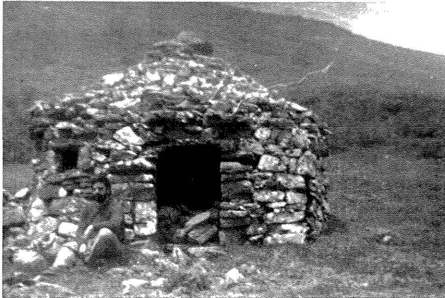
Kórru de la braña de Lágil. Es de planta circular y tejado cónico de piedra. En otras brañas observamos que abunda el techo de « tapínus »; el empleo que se les da en la actualidad está resumido al cobijo de « xátus ».
