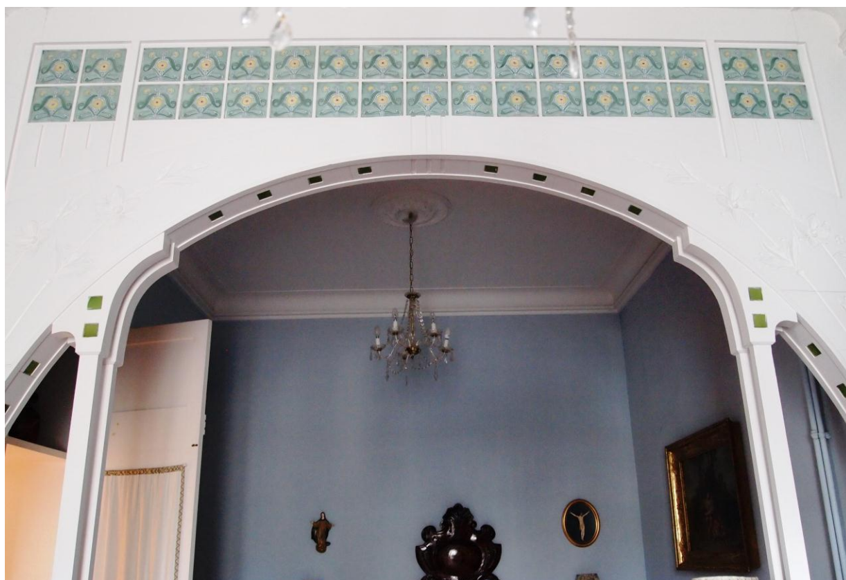
Fig. 10. Casa Rey (1911). Arco del gabinete a la italiana de una de las viviendas. (ARCHIVO Isabel Barro)
