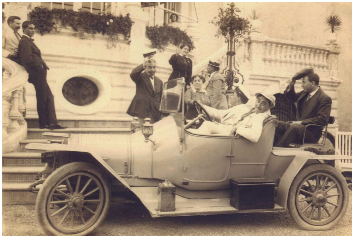
Fig. 1. Salvador Albacar (saludando con la gorra en las escaleras) en Villa Victoria. Fotografía del archivo del autor.
