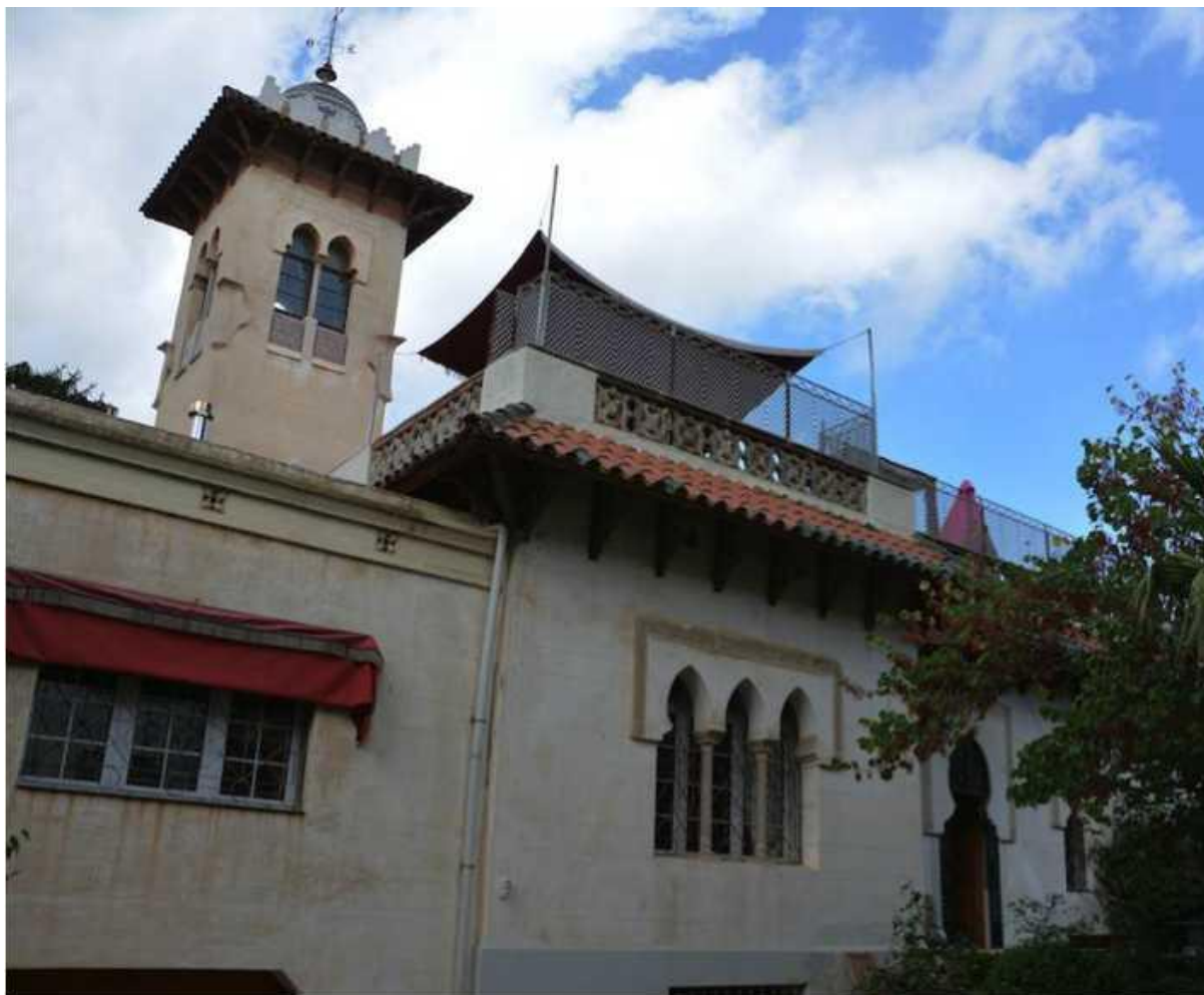
Fig. 3. Fachada principal de la Villa Hispanoárabe (2013) © Consol Bancells
