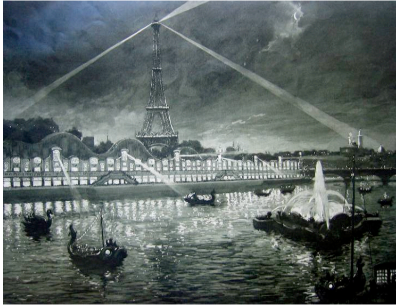
Fig. 1. Vista da Fachada ondulante (C. H. Besnard) que cobria a estrutura de base do comboio panorâmico. L'Illustration (25 Avril 1925): 49.
