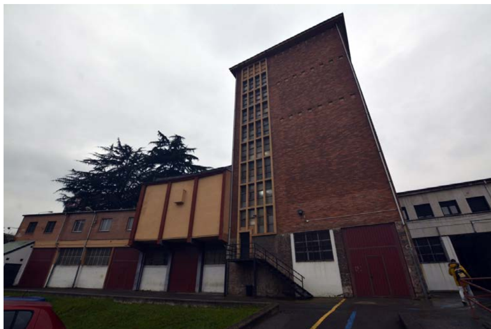
Fig. 7. Vista exterior del edificio de Maestría Industrial. Fotografía: Rubén Domínguez Rodríguez.
