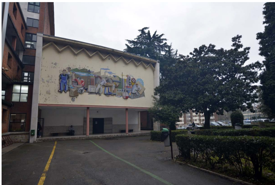
Fig. 8. Fachada principal del salón de actos, abierta a la plaza interior. Fotografía: Rubén Domínguez Rodríguez.
