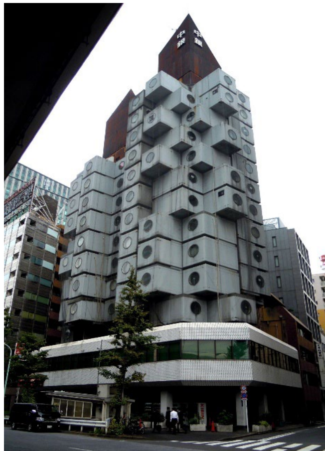
Fig. 12. Imagen de la Torre de Cápsulas Nakagin unos años antes de su demolición (2016), con ausencia de las persianas en la mayoría de los huecos. © A.L.R..
