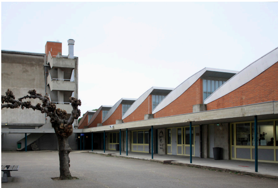
Fig. 2. Fotografía del patio este del instituto Jean Mermoz, vista de los talleres y las características arquitectónicas. Autora de la fotografía: Carole Aragon (2025)
