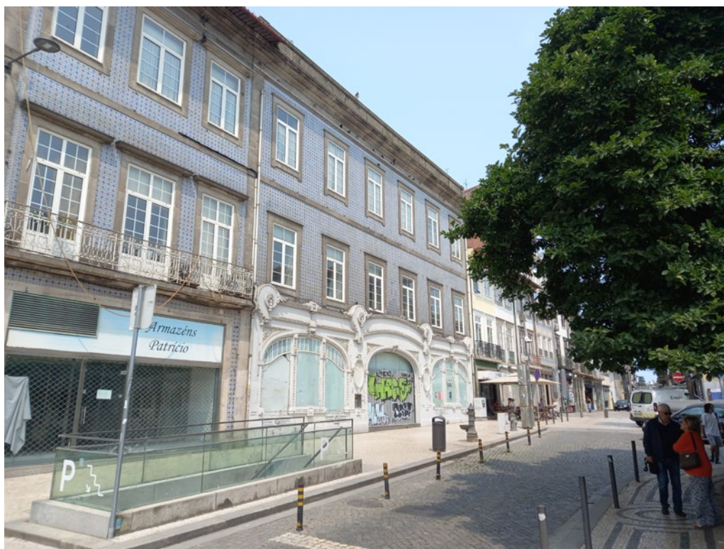
Fig. 2. Fotografia da fachada do antigo edifício da casa Cipriano d'Oliveira e Silva & C.ª, na Praça de Carlos Alberto, no Porto (posteriormente remodelada a nível do piso térreo). Fotografia Licínio Santos.
