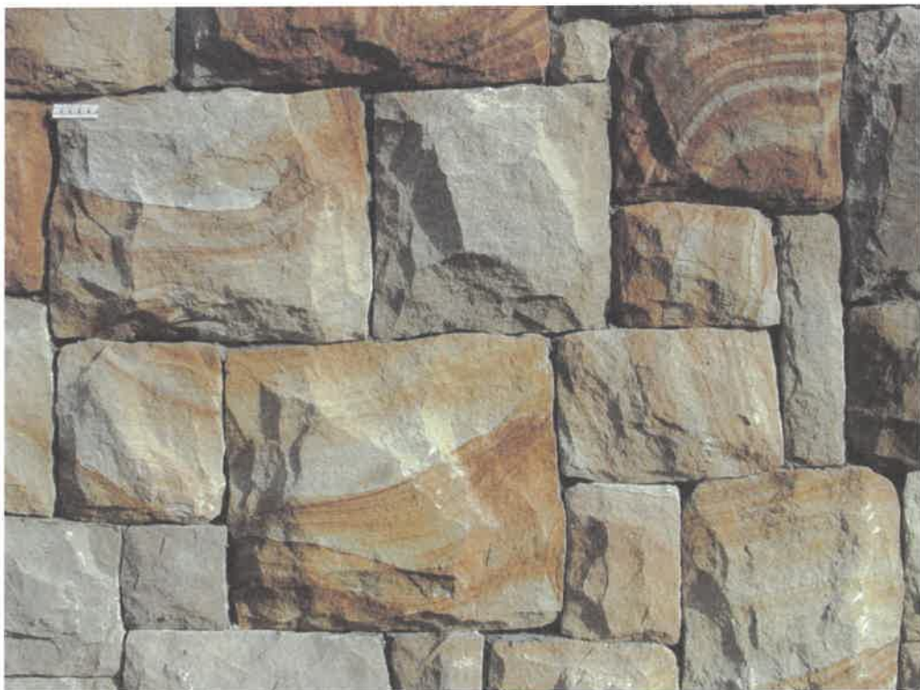
Figura 9. Detalle de un muro construido con la arenisca jurásica amarilla. Escala: 5 cm.
