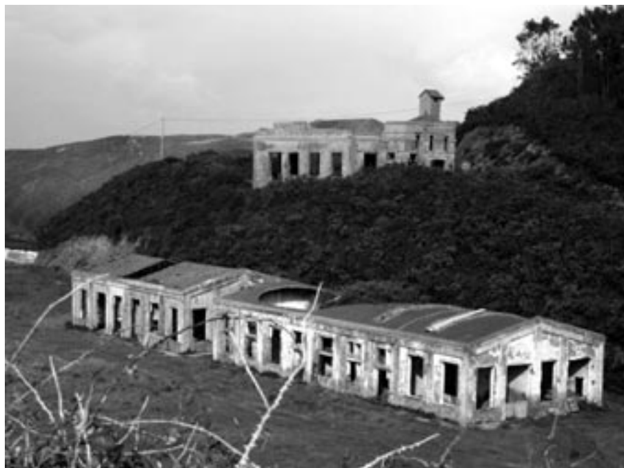
Figura 14. Instalaciones de la Mina de Llumeres (Gozón), testigos del período más boyante para el hierro.
