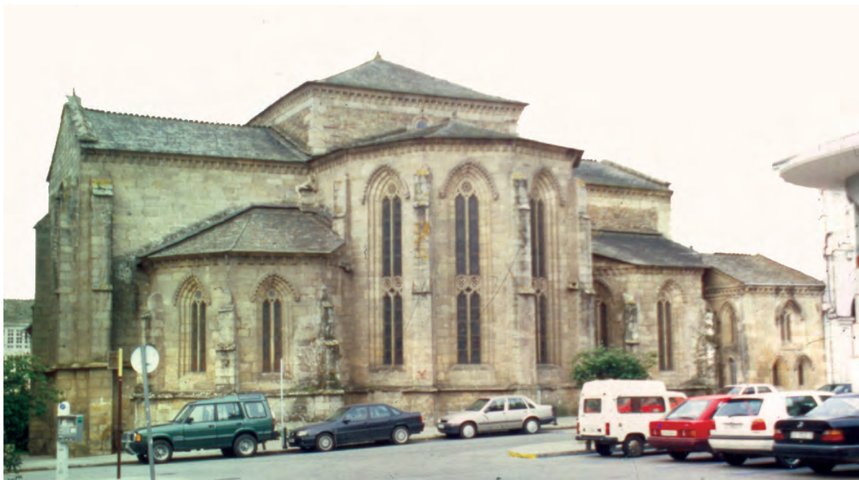
Figura 26.- Monasterio de San Francisco de Lugo. Cabecera poligonal con contrafuertes en esquina y grandes ventanales, característica de los conventos mendicantes (foto A. Gutiérrez).
