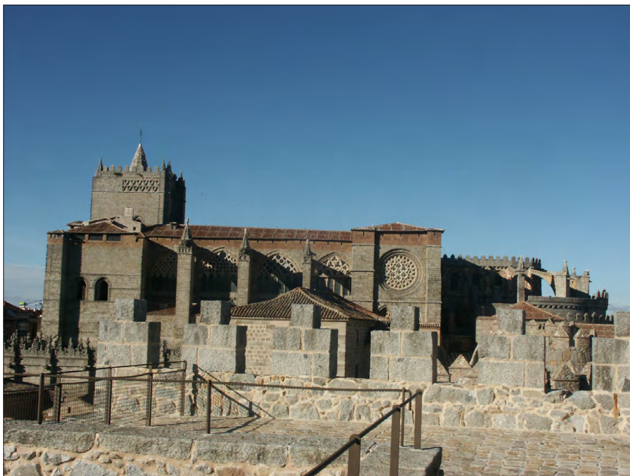
Figura 6.- Catedral de Ávila, cuerpo de la nave y cabecera tardorrománica integrada en la muralla urbana (foto A. Gutiérrez).
