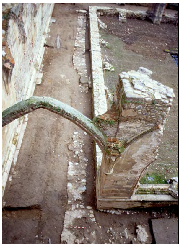
Figura 19.- Monasterio de Carracedo (León). Cimentaciones del claustro medieval destruido en el siglo XVI para la construcción del nuevo claustro (foto F. Miguel).
