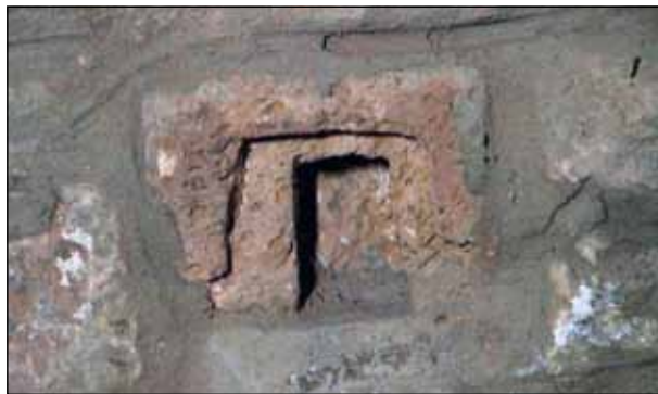
Fig. 9 - San Pedro de Nocito. Reconditorio murario.
