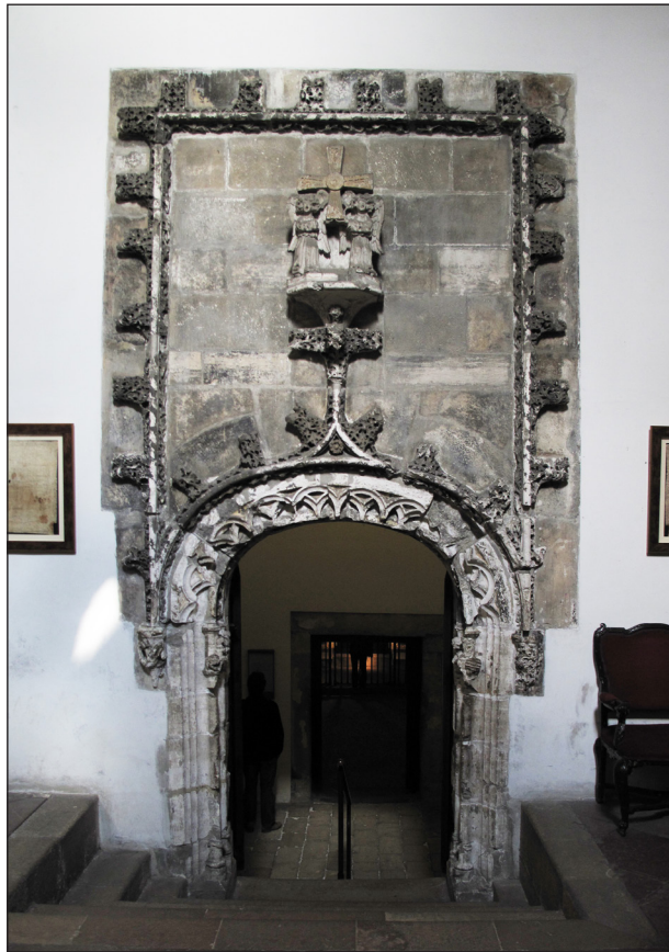
Fig. 9. Catedral de Oviedo, acceso a la torre de san Miguel, desde la estancia entre el transepto y la torre románica.
