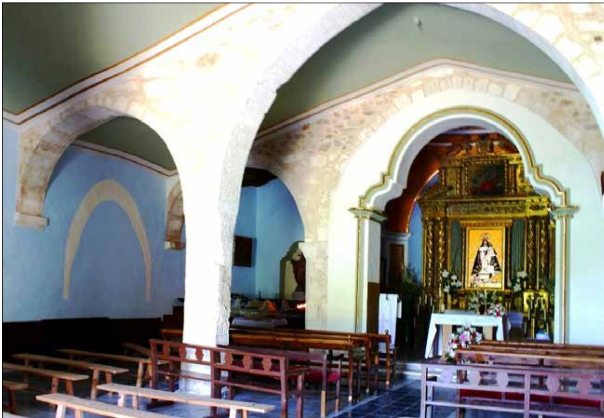
Fig. 1: Interior de la iglesia de Santa María de Cilleruelos, s. XIII, vista general de los arcos diafragmas y pilares con capiteles retallados en el s. XV.
