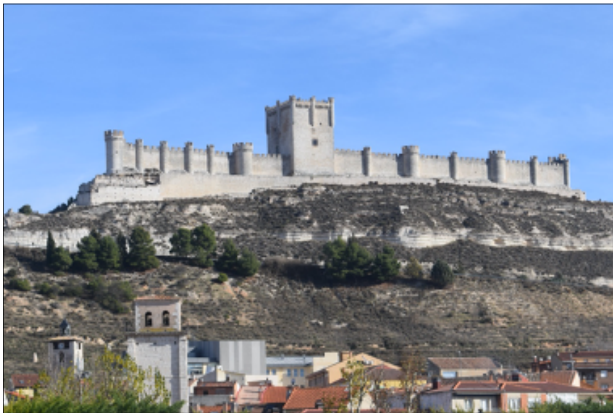
Figura 2: Vista general del castillo de Peñafiel (Valladolid). Fotografía propia.
