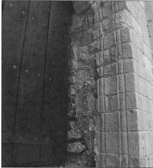
Fig. 29.- Huella de la jamba original de la ventana derecha de la fachada norte. Se percibe el emplecton original.
