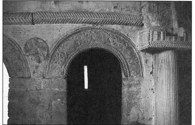
Fig. 6.- Detalle del arco monolítico de la habitación norte, con la columna del arco toral y el clípeo de la enjuta del arco
