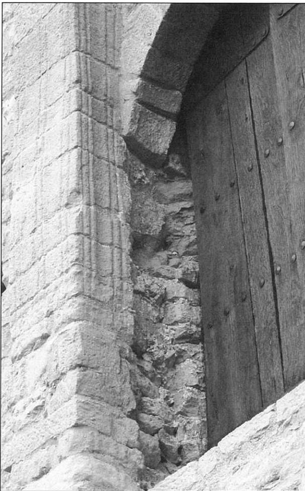
Fig. 25.- Huella de la jamba original de la ventana izquierda de la fachada norte. Se percibe el embleton original
