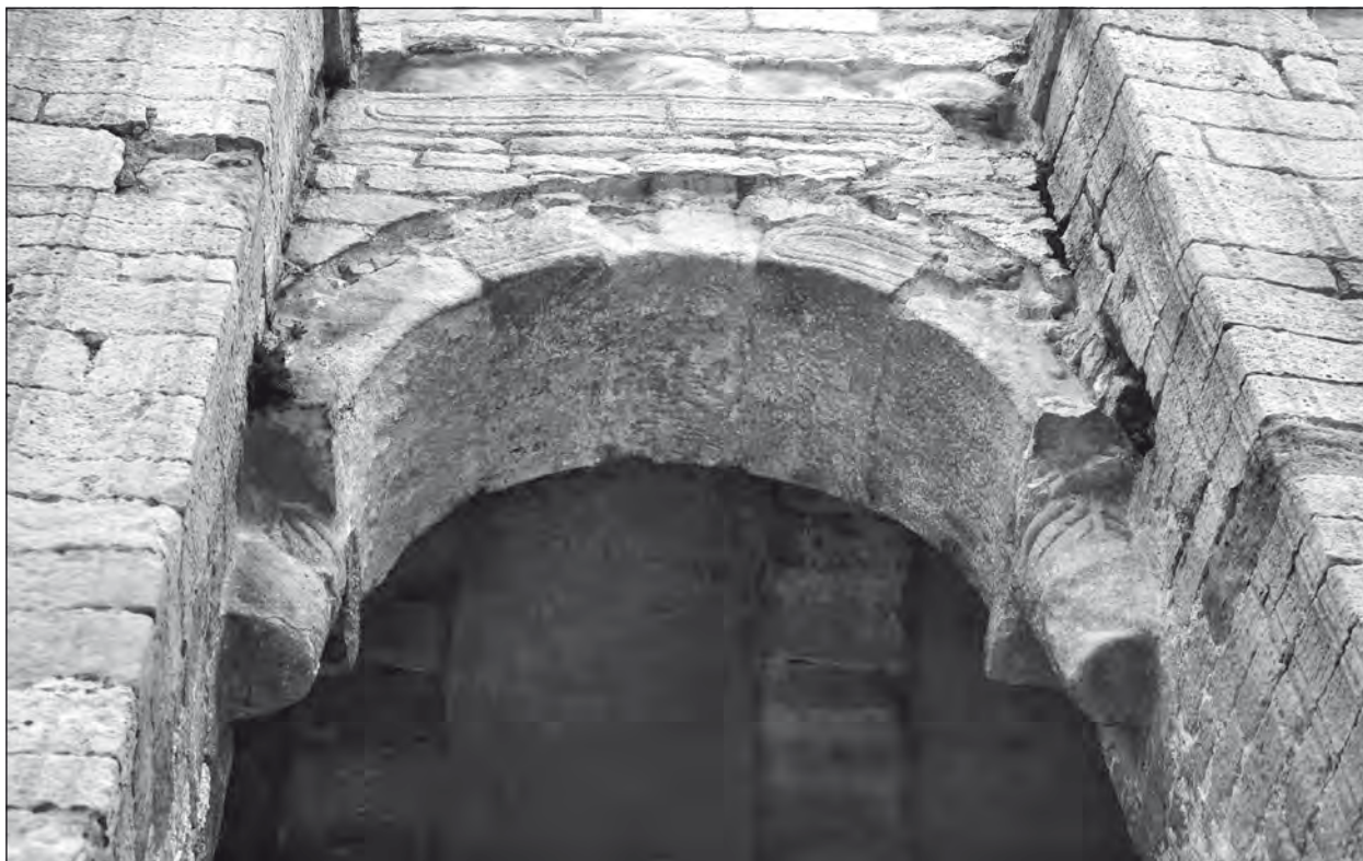
14. Detalle de todo el arco reconstruido y su forzado encaje
