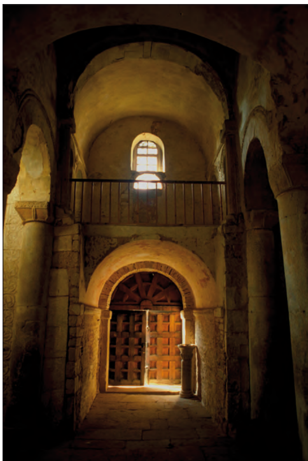
3. Interior hacia occidente con la disposición de la tribuna y el primer tramo conservado de la arquería de la nave
