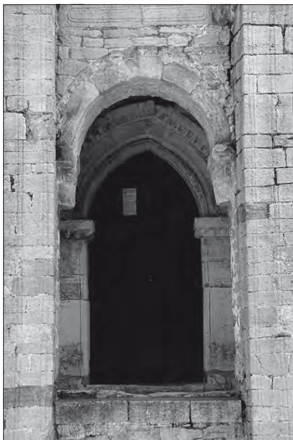
10. Arco central del vestíbulo. Estado actual
