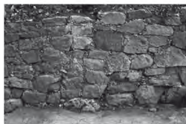
Detalle de la fábrica con mampostería careada y argamasa
