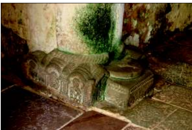
Láminas 44 a 46.- 44 y 45. Detalles del testero sur del crucero de pies, con su ventana. 46.- Columna nordeste del tramo de crucero, en la entrada al ábside. (Fotos Luis Caballero).
