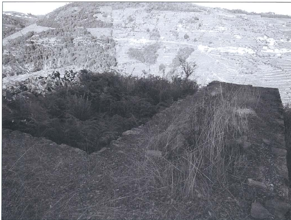
Figura 6. Alióvirio . Pormenor dos muros da torre do século x
